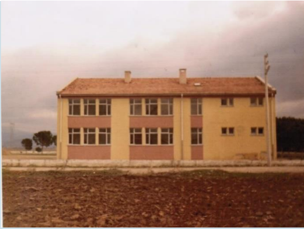
Şu anki okul binamızın 1998 yılında arka cepheden görünüşü
